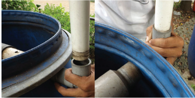
Gambar 6.15 Penyambungan cerobong udara
