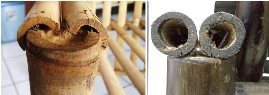
Gambar 5.10 Batang bambu pada *armrest* Model Versi 1A dibelah (kiri), sedangkan pada Model Versi 2A dibiarkan utuh (kanan).
